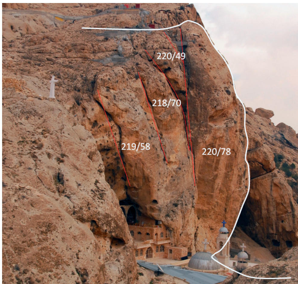
Distribuzione delle fratture con direzione e pendenze e volumi interessati dagli scivolamenti potenziali. In basso il Monastero di Santa Tecla con la cripta contenente la sepoltura della Santa e riferibile al I sec. d. C. (CLAUDIO MARGOTTINI)
